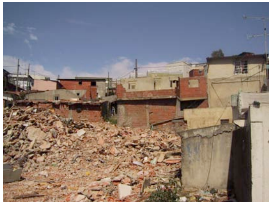
Quartier d'Azinhaga dos Besouros en cours de démolition
