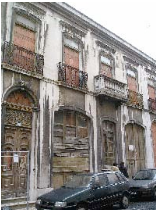
Immeuble muré de la rue Sao José
