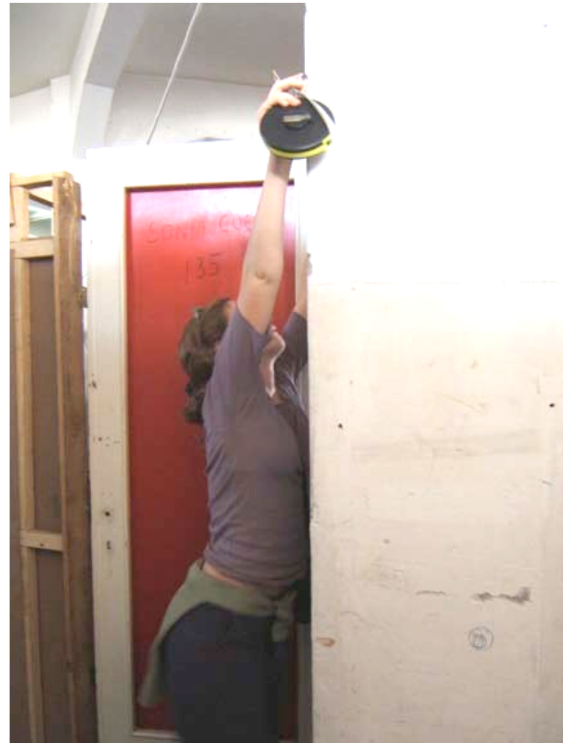
Manon en train de mesurer la structure du bâtiment
