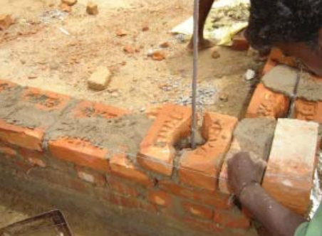
FORMATION Les maçons apprennent à renforcer les ceintures des murs
