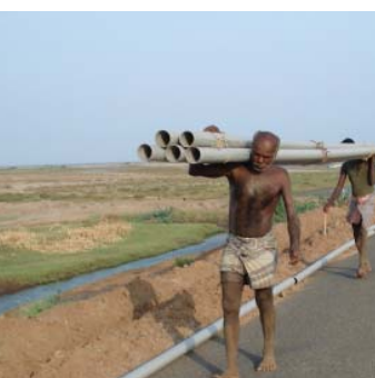
INSTALLATIONS L'installation du réseau d'eau est en cours
