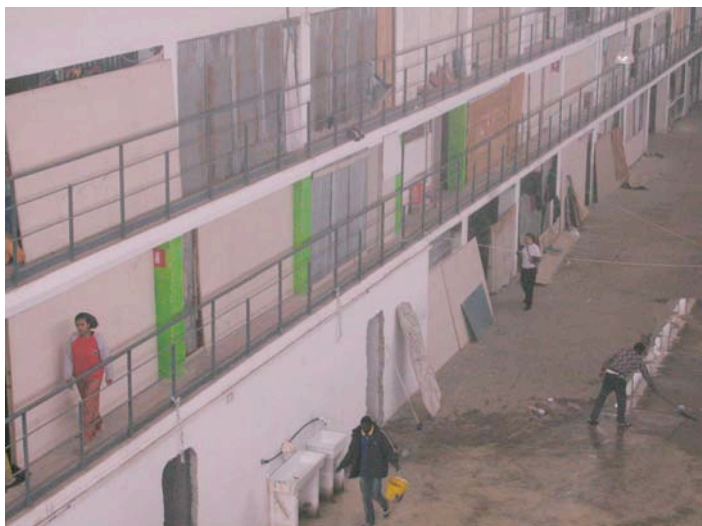
Le bâtiment occupé de Tiburtina à Rome
