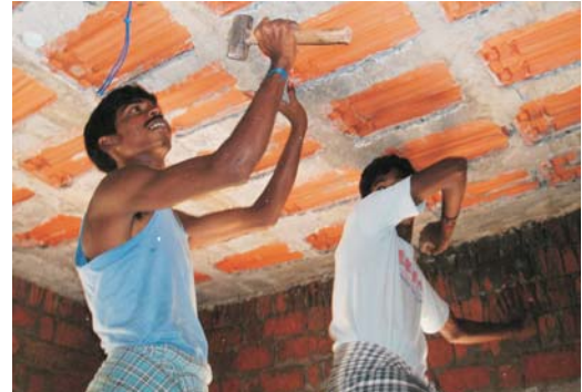
Formation de maçons à Nagapattinam
