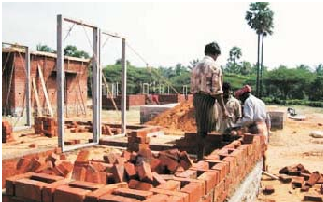
Le Village de Veerapagupathi en Novembre 2005 - Détail des fenêtres en ferrociment
