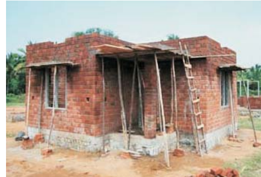
Maison en construction à Veerapagupathi
