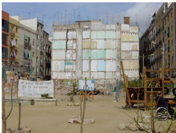
La reprise des démolitions menace de nouveau l'avenir du « Forat »
