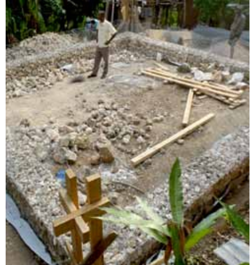
Semelle continue et soubassement en MPC
